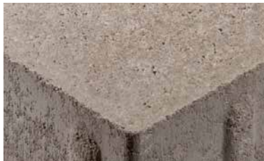
linear unbehandelt / betonglatt (mit und ohne Fasse)
