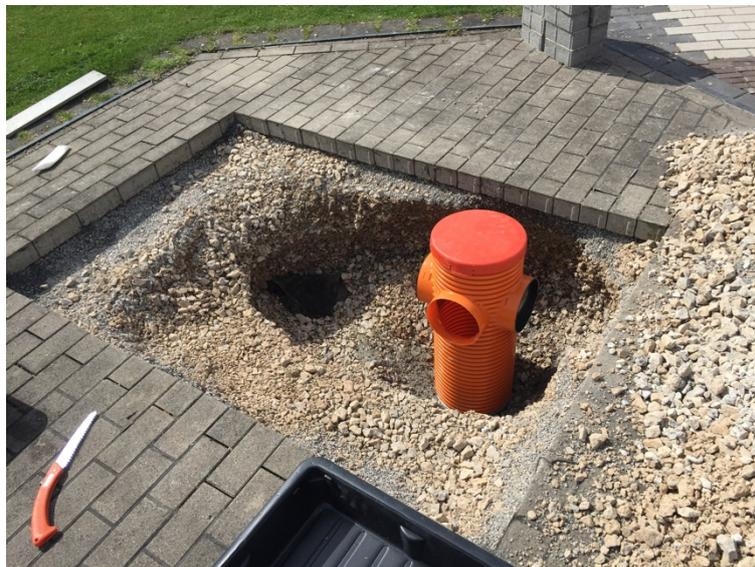
Abbildung 6: Einbau der Messschächte
