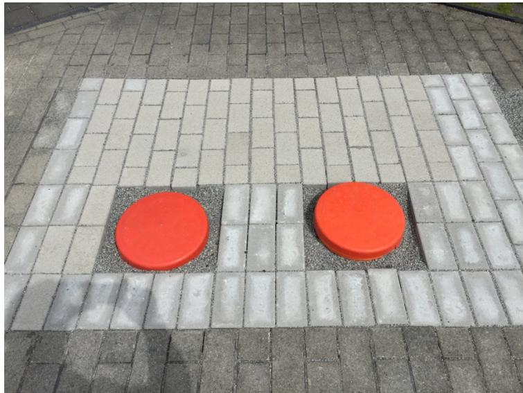
Abbildung 8: Lysimeter nach Einbau
