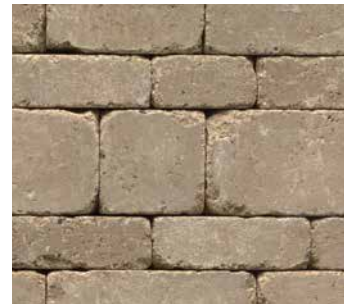
als Schichtenmauerwerk
